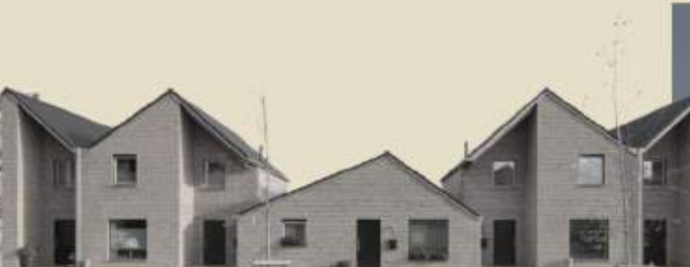
Δίρριχτες εμφανείς στέγες
